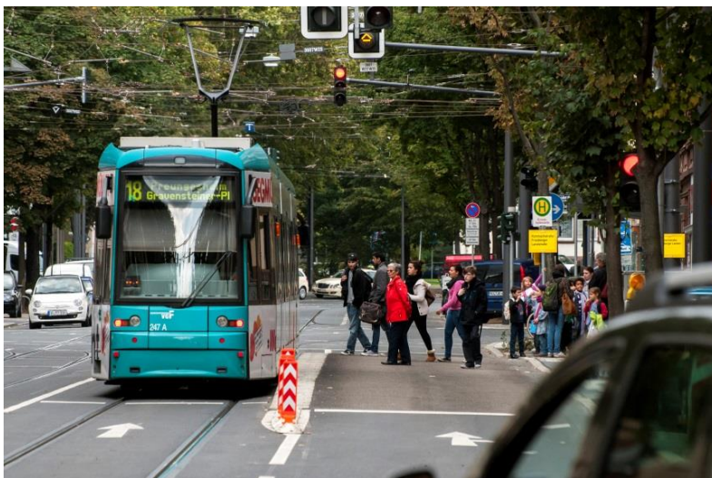
Abb. 2: Straßenbahnstrecke in Frankfurt am Main mit straßenbündigem Bahnkörper
