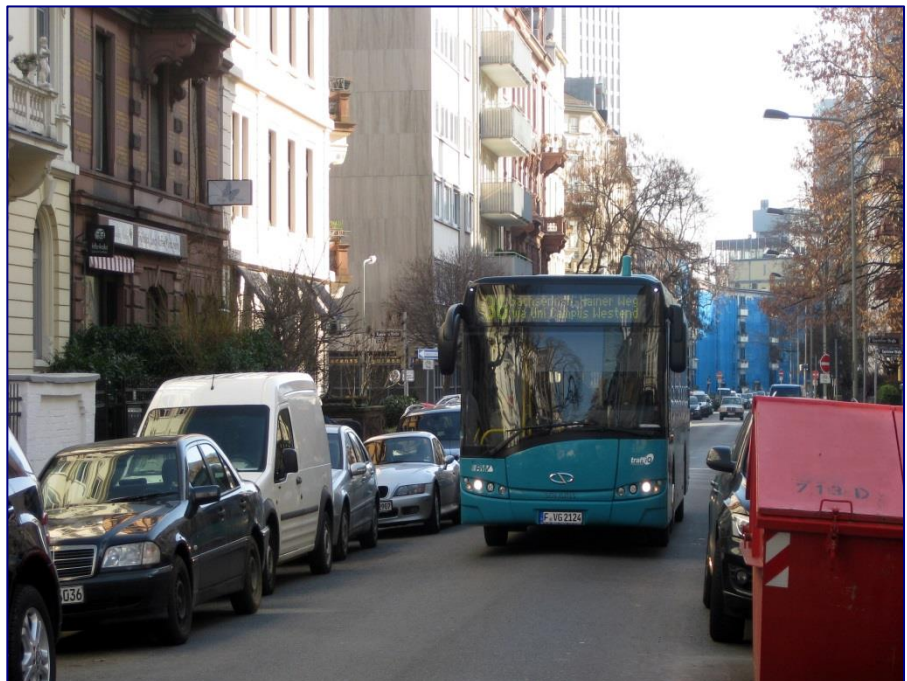
Abb. 1: Mehrere Buslinien werden in Frankfurt am Main durch Gründerzeitquartiere mit engen Straßenräumen geführt. Rechts-vor-Links, ungeordnetes Parken und andere Störpotenziale haben hier ein Geschwindigkeitsniveau von unter 12 km/h zur Folge.
